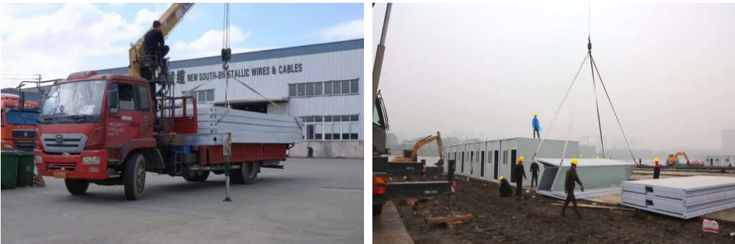
图11 打包箱房运输与吊装。
